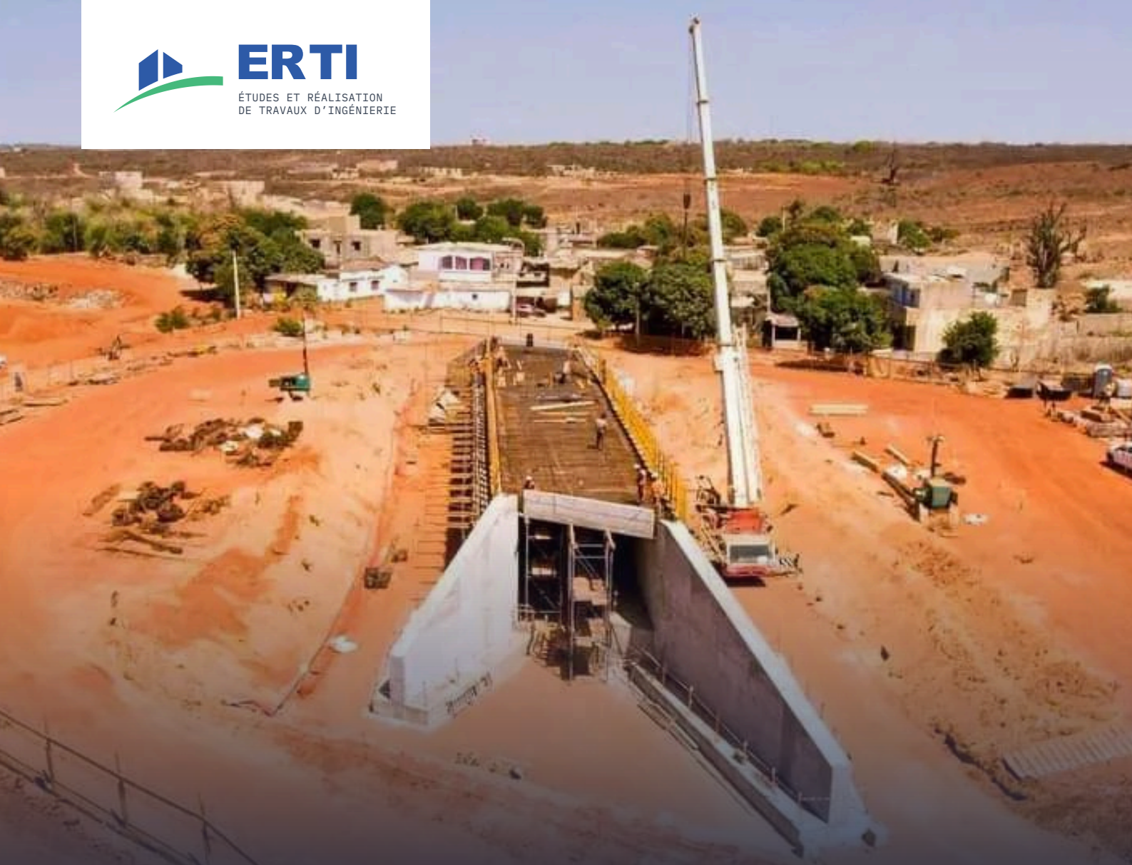
Ferraillage du tablier de l'ouvrage hydraulique du PK45, TER Diamniadio-AIBD
