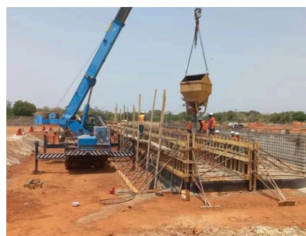
Grue mobile et benne à béton sur un ouvrage
